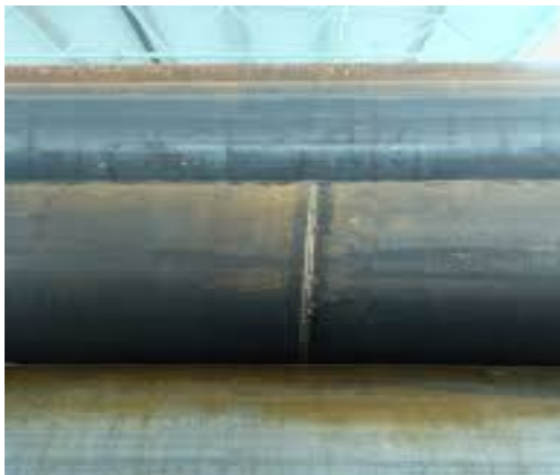
Поперечный сварной шов
