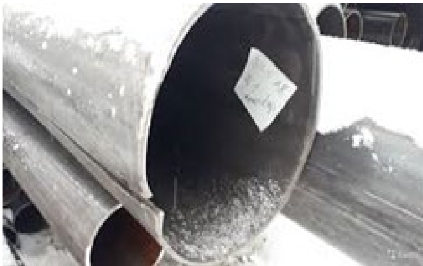
Непровар сварного шва
